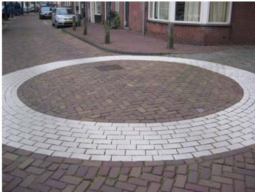
Foto 3.3.1.: Hoogteprofiel: snelheidsremmer "paddestoel": niet meer toepassen
