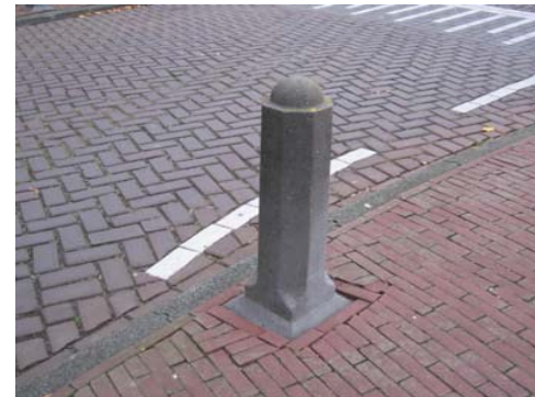
Foto 3.5.2.: Aanvaardbaar alternatief: betonnen Alphenpaal.
