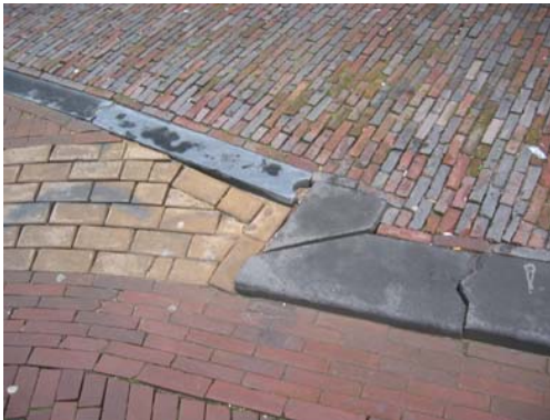
Foto 3.2.1.: Voorbeeld gebrekkige detaillering: Rivierischmarkt
