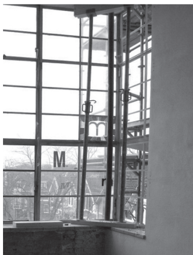
De doorgebogen steunpaal op de plek waar zetting een hoogteverschil van 14 centimeter heeft veroorzaakt.
