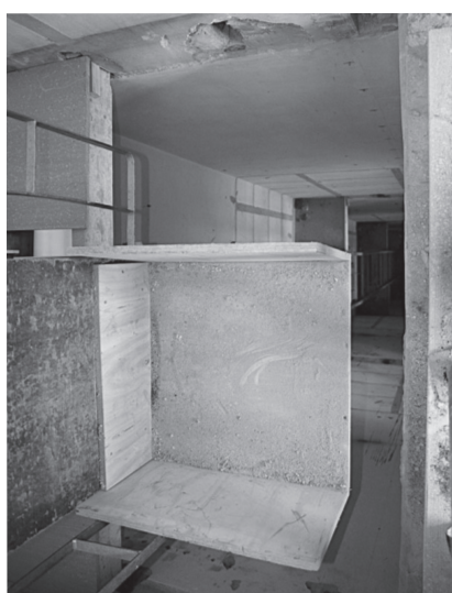
Uitgebroken kasten vormen de schacht voor de inpandige bouwlift en straks voor de nieuwe personenlift.
