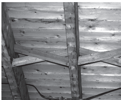
Straks weer aan het oog onttrokken: de verstevigingskruisen die zorgen voor een extra stijve houten vloer.
